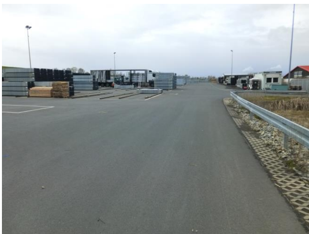
Abb. 1: Bestand: bestehende nördliche Lagerfläche
