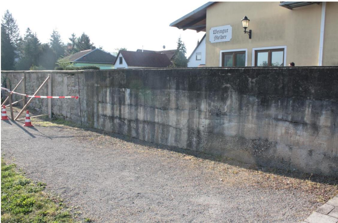
Die einsturzgefährdeten Mauerbereiche wurden abgesichert, rechts im Bild der Mauerabschnitt, der nach aktuellen Überlegungen schließlich nicht zurückgebaut wurde, sondern mit Riemchen verblendet werden soll
