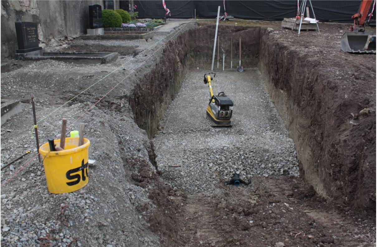
Aushub der Baugrube für die Grabkammern einschließlich Schotterunterlage
