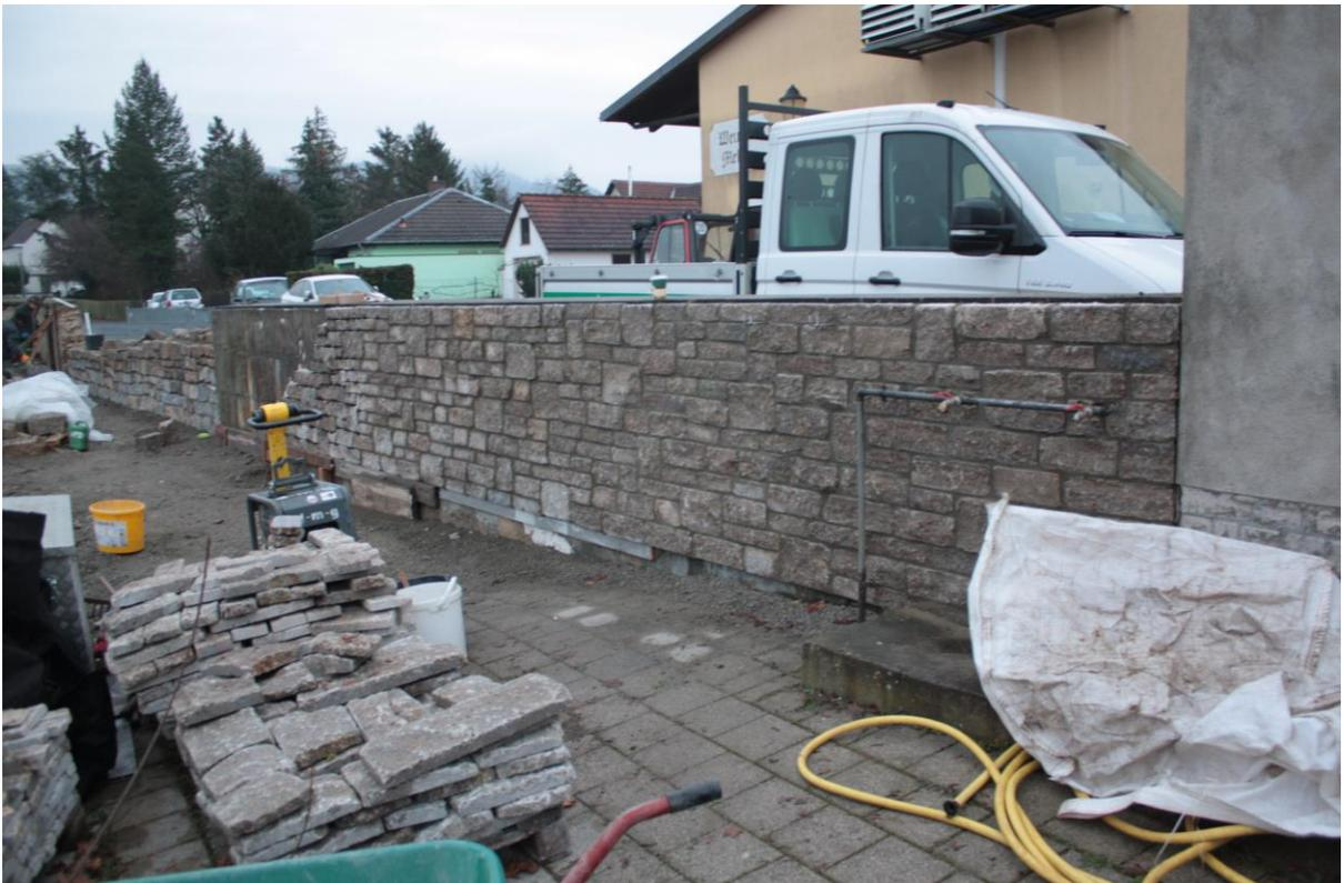
Die Mauerverblendung ist noch restlich fertig zu stellen und wird bei der Abnahme als Restarbeit festgehalten
