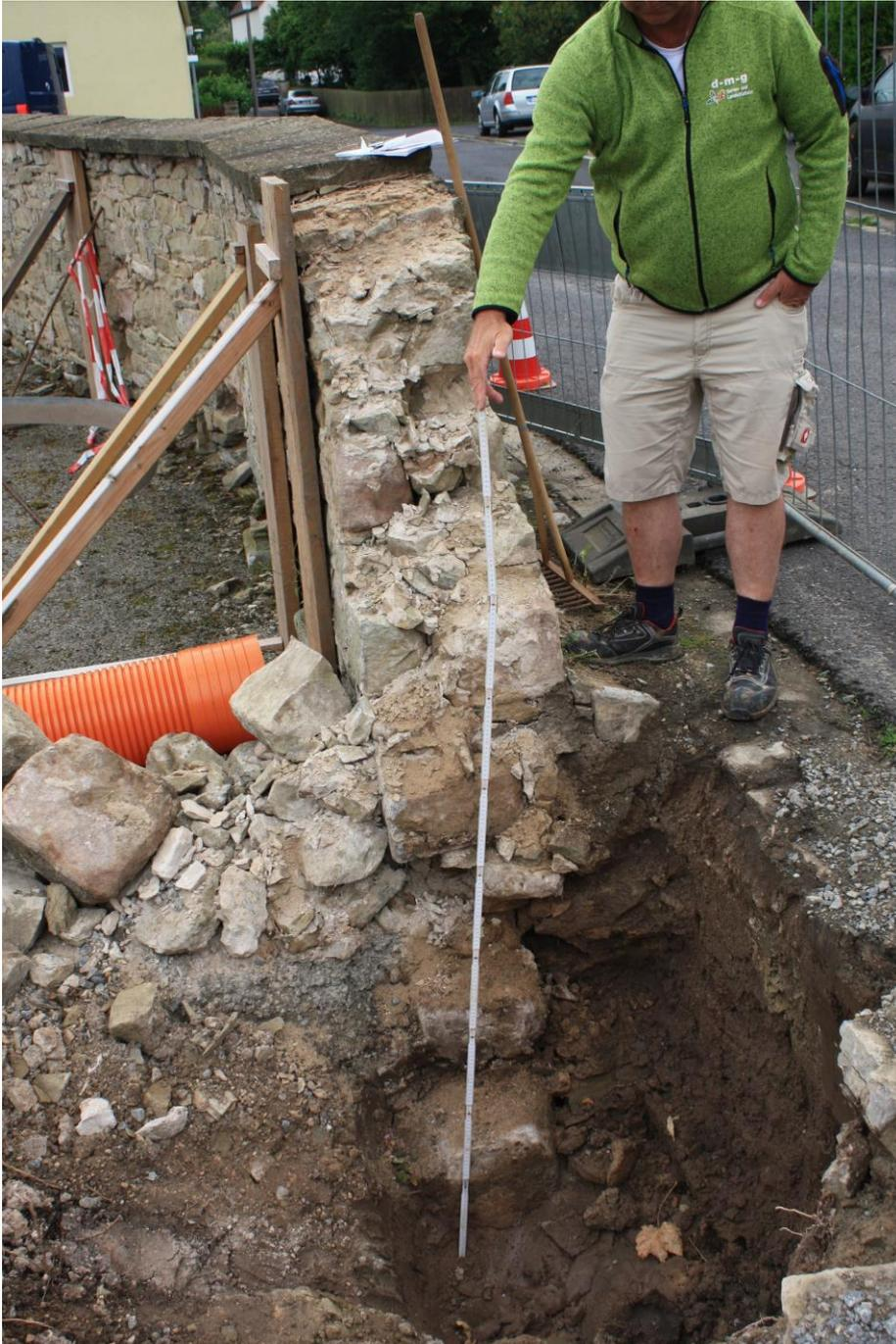
Bestandsaufnahme der alten Fundamentierung, Vorbereitung des neuen Mauerfundaments
