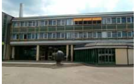
Ehrenbürg-Gymnasium Forchheim vor der Sanierung
