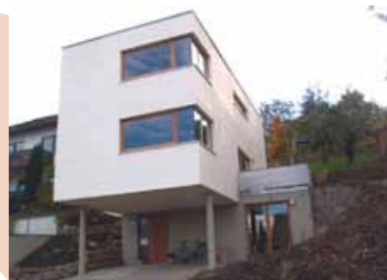
Eingangsansicht mit Carport
