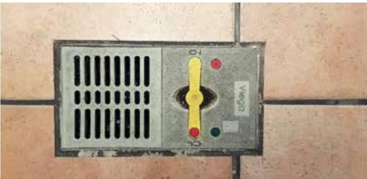
Manuell bedienbarer Rückstauverschluss
